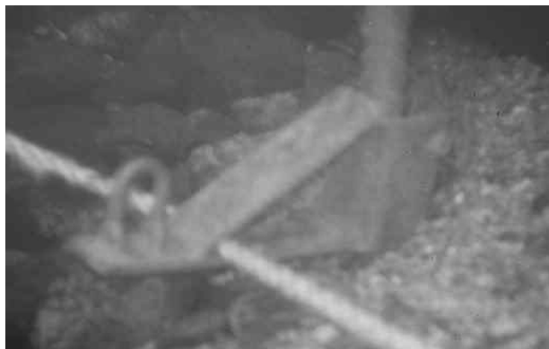
Kuva 6. Köyden kiinnitysmenetelmä harjaterästankoon poikkivirtaan pystytetyllä linjalla.
